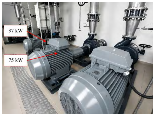
Sl. 6-42 Paralelno vezane pumpe upravljane jednim VFD uređajem [99]
