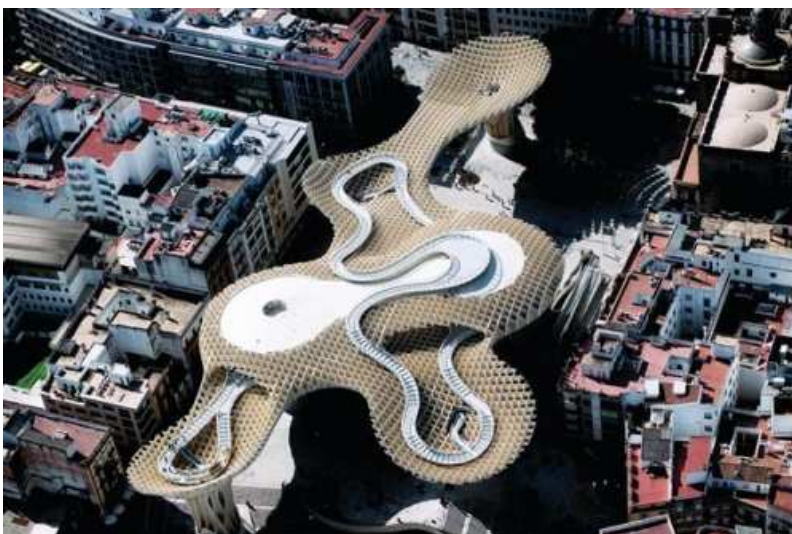
Слика бр.4. Сармене дрвене конструкције, лепљено ламелирано дрво, (ЛЛД) примењују се и као надстрешнице читавих јавних простора. на слици је Метропол Парасол, пример из Шпаније у граду Севиља .
