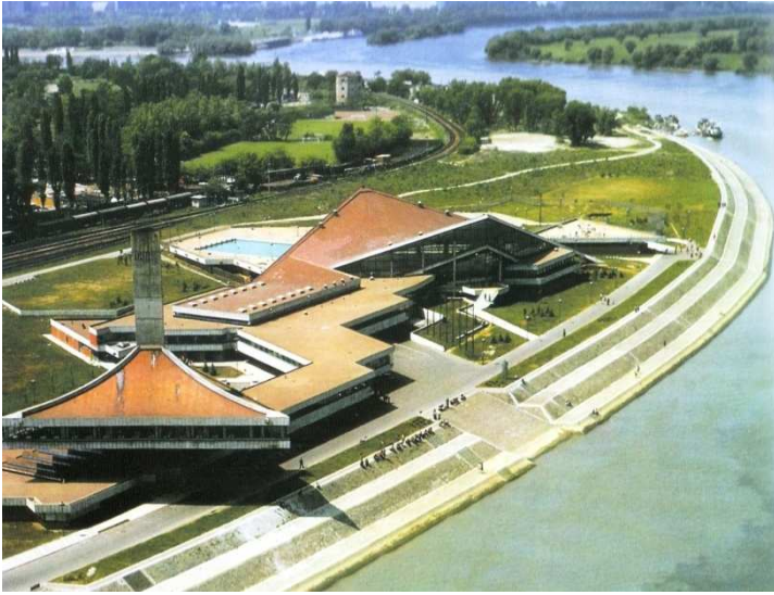
Слика 1 Спортски центар 25. Мај у Београду. У првом плану је ресторан, док се у другом плану види кровна конструкција затвореног базена. Базен је засведен АБ хипар ( хиперболични параболоид ) љуском .
